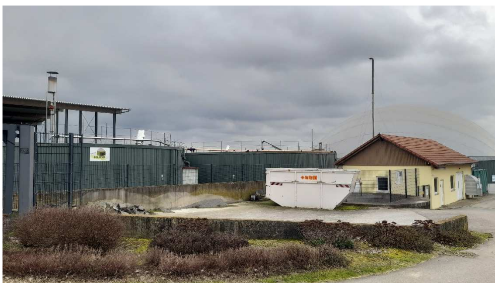
Abb. 3-5: Blicke über das Plangebiet
